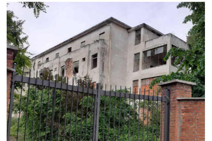
04 - vista della corte interna
