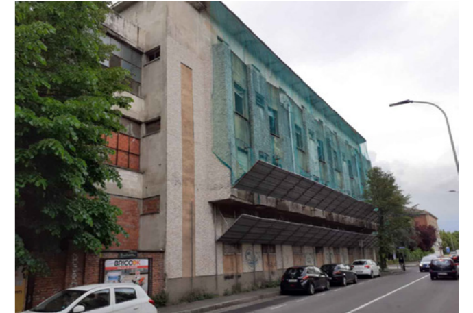
02- vista edificio attualmente demolito lungo viale Circonvallazione
